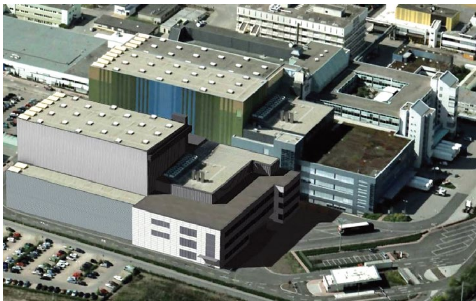
Складской комплекс в г. Манхайме, Германия
